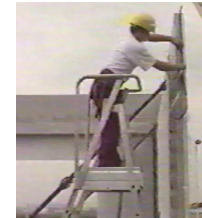
Mise en place des joints verticaux
