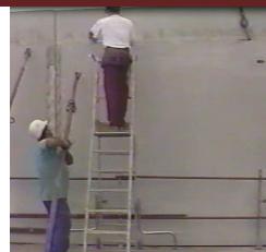
13 Mise en place des bâches de protection
