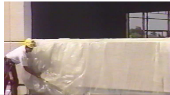
13 Mise en place des bâches de protection
