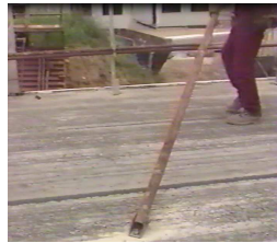
Fixation des tirants-poussants sur le plancher
