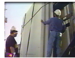
5 Vérification des panneaux avant pose
