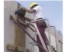
Clavetage des panneaux
