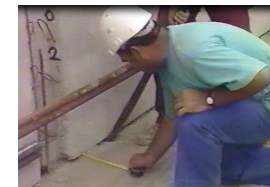
Positionnement du panneau (alignement)
