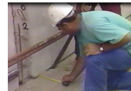
Positionnement du panneau (alignement)
