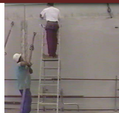
13 Mise en place des bâches de protection
