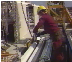
Elingage des panneaux sur le camion
