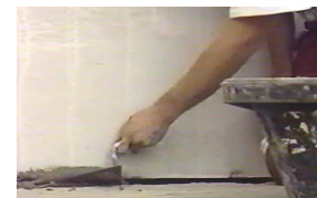
Remplissage du joint
