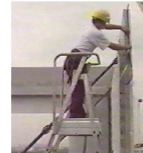
Mise en place des joints verticaux
