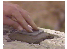
Mise en place des cales (niveau)
